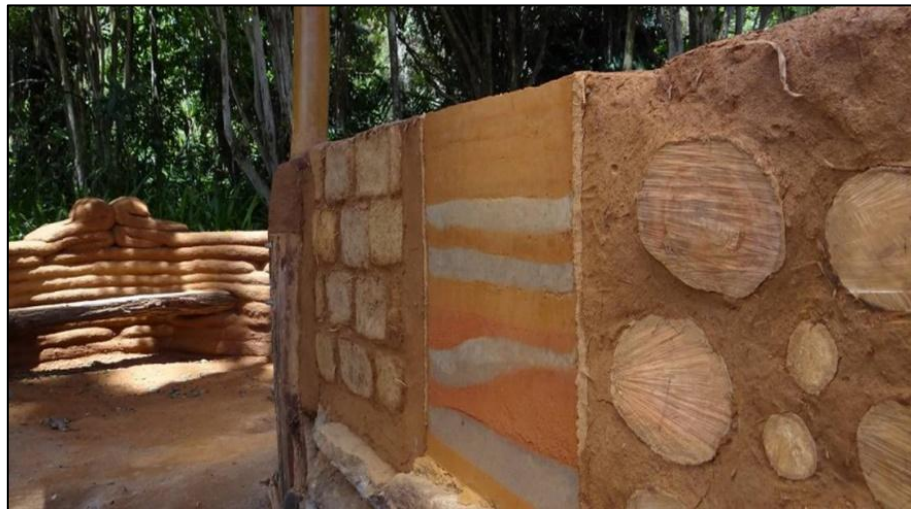
Figura 1. Materiais utilizados na bioconstrução
