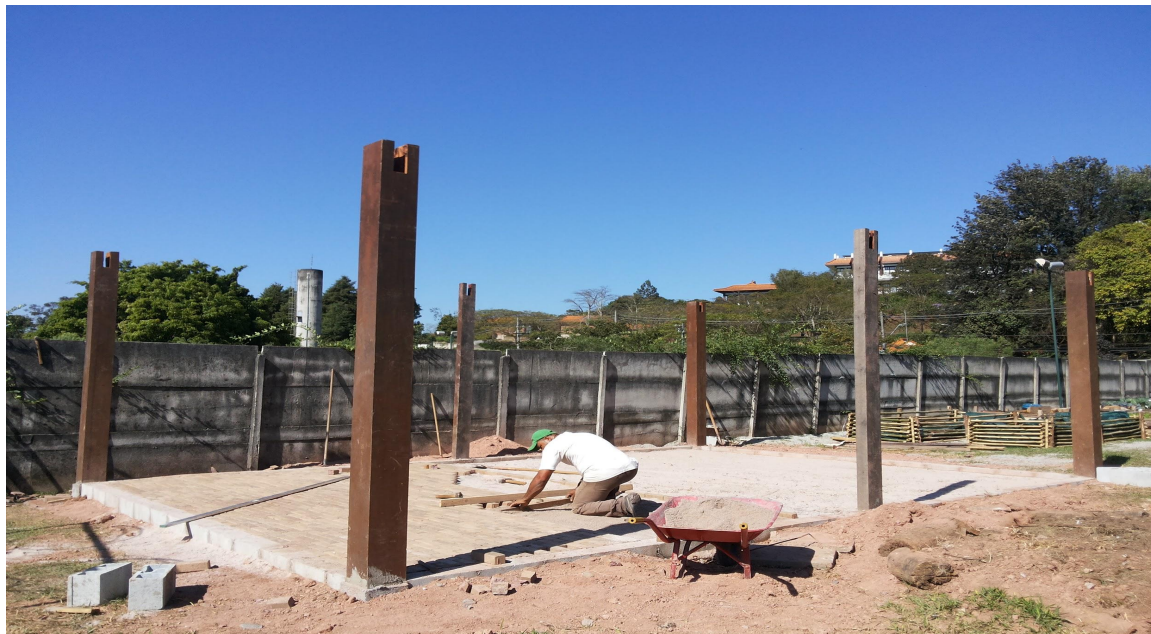
FIGURA 18. Preparando terreno para fundação do bioquiosque
