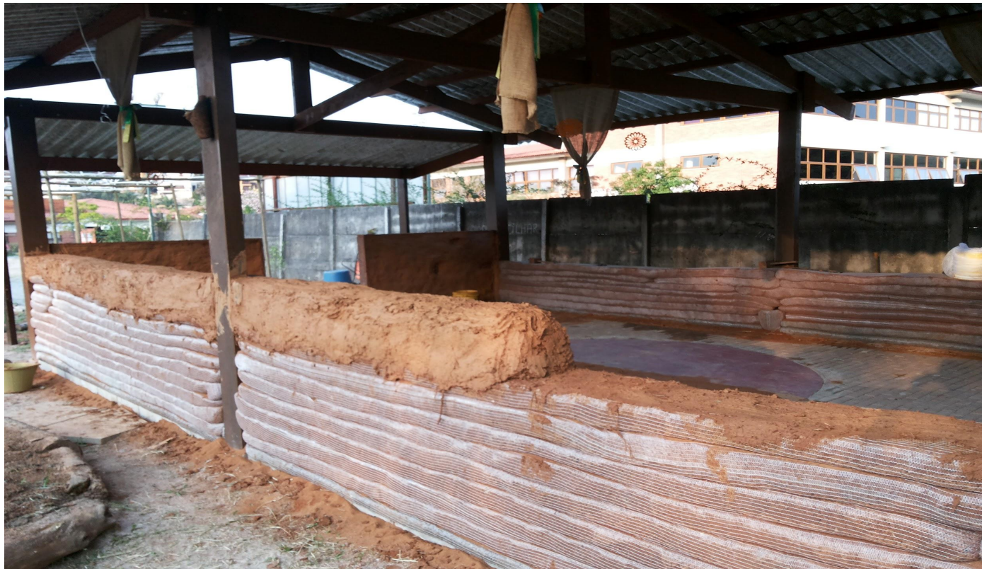
Figura 23:paredes sendo construídas com hiperadobe e cob
