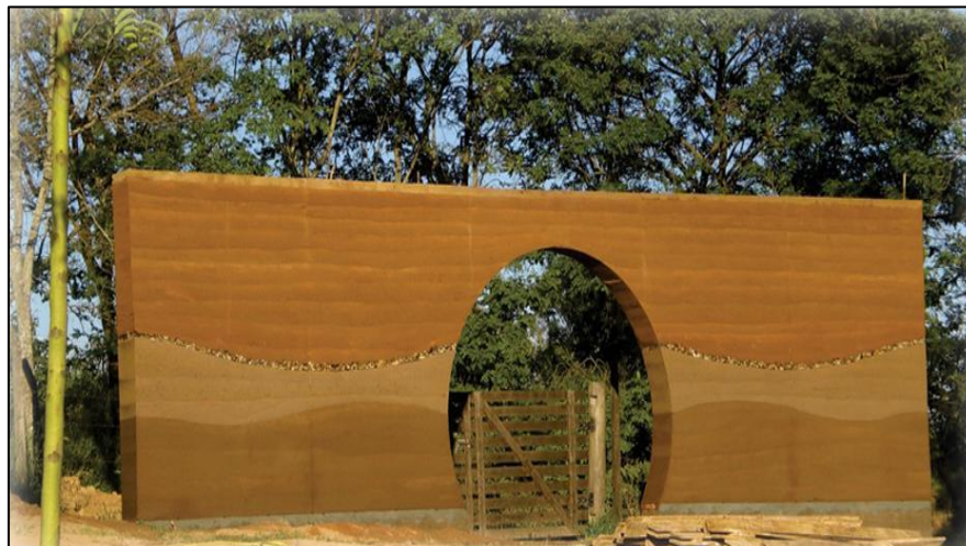
Figura 5. Técnica Taipa de Pilão
