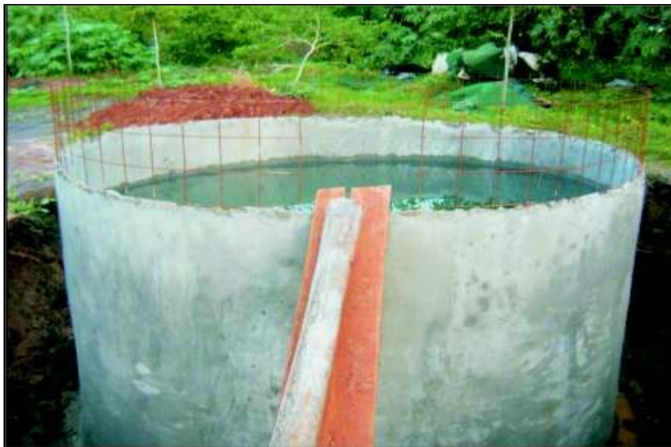
Figura 6. Técnica Ferrocimento Cisterna no IMCA (Instituto Morro da Cutia, RGS) Fonte: Curso de Bioconstrução
