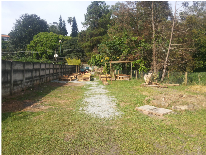
Figura 16. Espaço da horta em construção
